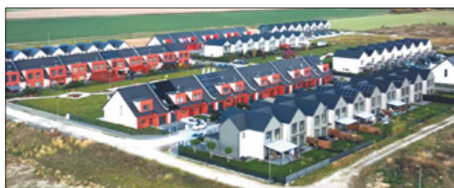
Osiedle Reńskie w Oławie. Panele PV są rozwiązaniem opcjonalnym, więc nie wszyscy mieszkańcy decydują się na jego zastosowanie. Źródło: Osiedle Reńskie
