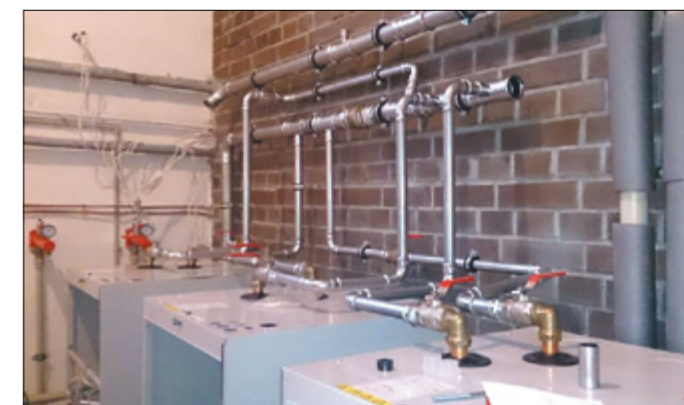
Fot. 4. Maszynownia w trakcie montażu w technologii stali zaciskanej. Źródło: Zelga Instalacje
