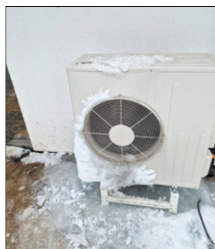
Fot. 6. Zamarzająca jednostka zewnętrzna pompy ciepła Źródło: Zelga Instalacje
