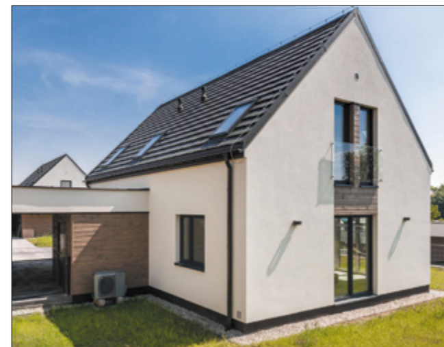
Pompy ciepła i fotowoltaika na osiedlu „Domy Przyszłości” w Libertowie k. Krakowa. Źródło: HausWerk
