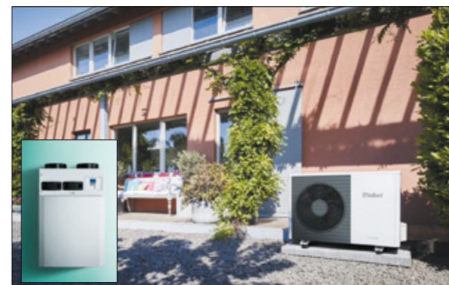
Pompa ciepła typu split i rekuperator zastosowane na osiedlu domów energooszczędnych „Grabowe” w Dąbrowie Górniczej. Źródło: Vaillant
