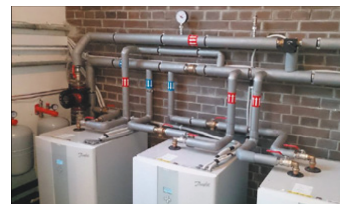
Fot. 5. Maszynownia w technologii stali zaciskanej po zaizolowaniu. Źródło: Zelga Instalacje
