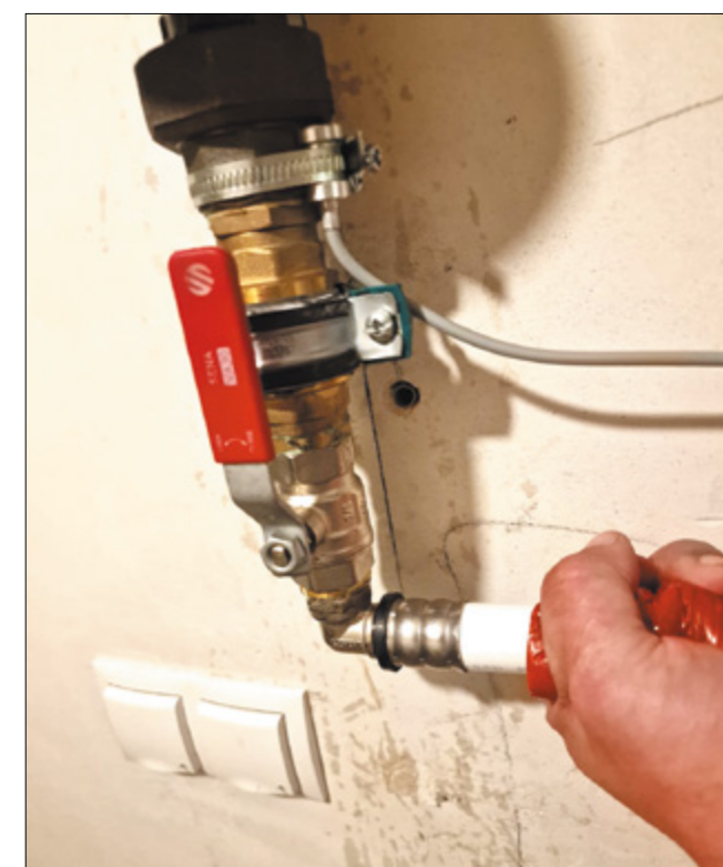
Fot. 2. Kolanko w technologii zaciskanej PEX Źródło: Zelga Instalacje
